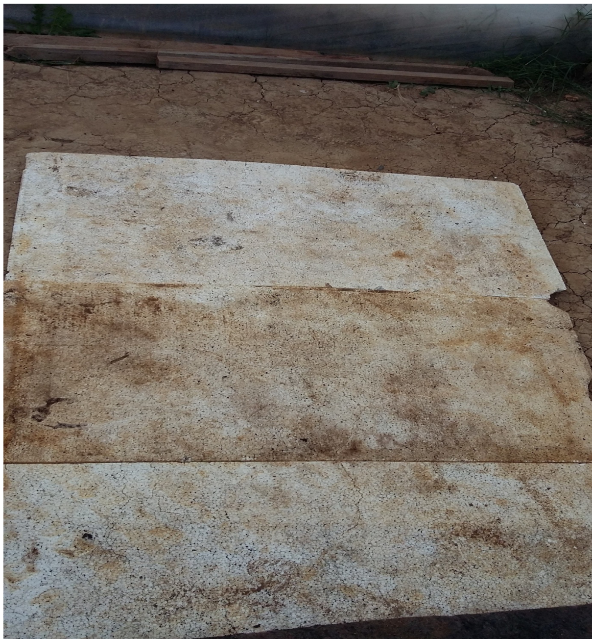
Slika 24. Postavljanje stiropora u red; foto Zečević B.
