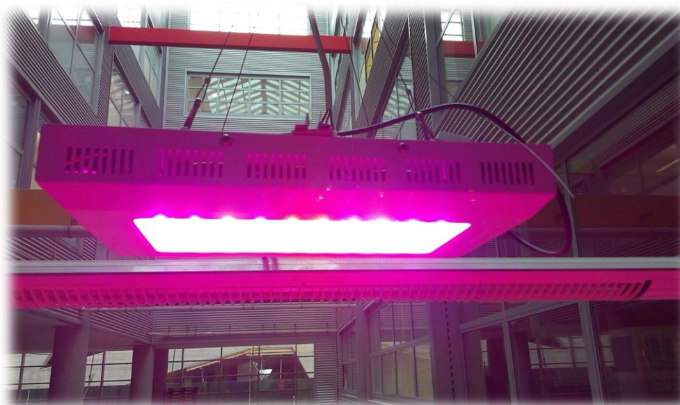
Slika26 led rasvjetno tijelo (300 W)
