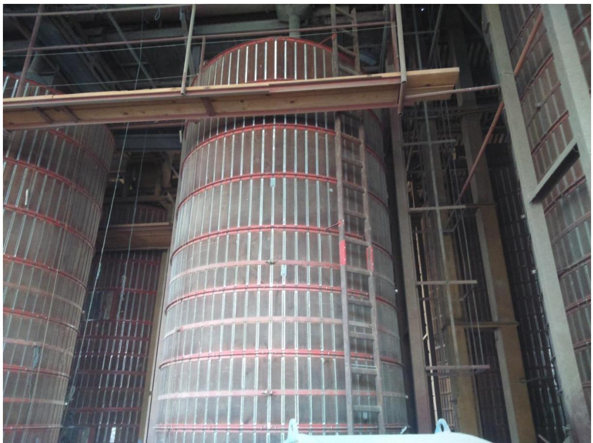
Slika 10. Perforirani valjkasti spremnik sušare (vlastita fotografija)
