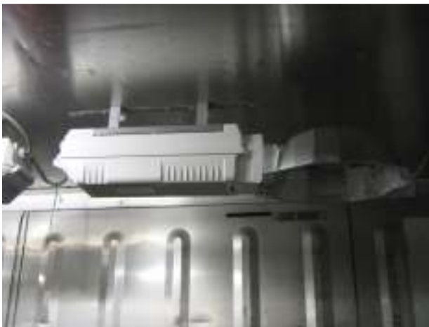
Slika 27. Reflektor Wide i HPS ili visoko tlačna natrijeva lampa snage 400 W HPS Philips Son T GreenPower. Autorska fotografija
