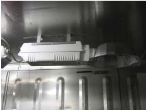
Slika 27. Reflektor Wide i HPS ili visoko tlačna natrijeva lampa snage 400 W HPS Philips Son T GreenPower. Autorska fotografija
