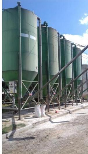
Slika 9. Vertikalni silosi
