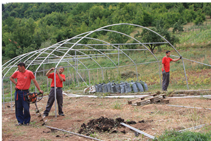
Slika 17: Montaža plastenika
