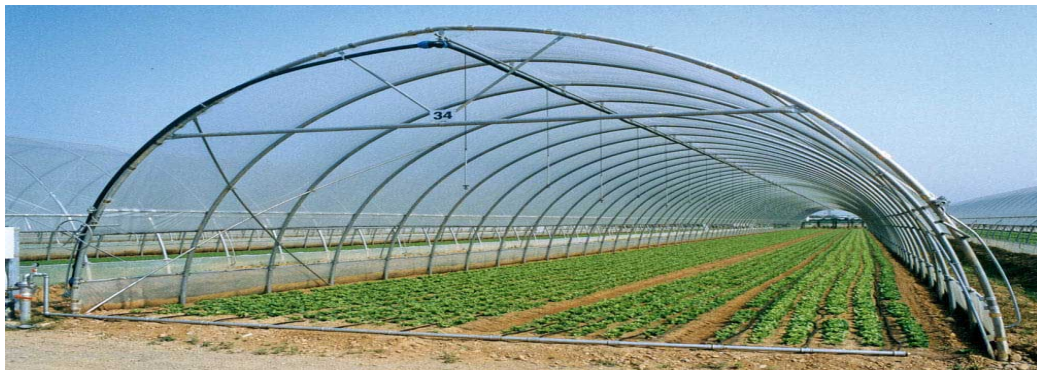
Slika 14 a i b: Izgled tunelskog plastenika (Izvor: http://euro-brod.hr/wp-content/uploads/2012/10/slide_default_3.jpg )
