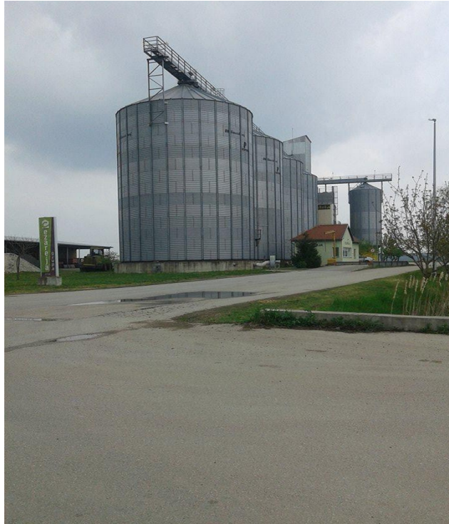
Slika 1. Silos Cezareje d.o.o.
