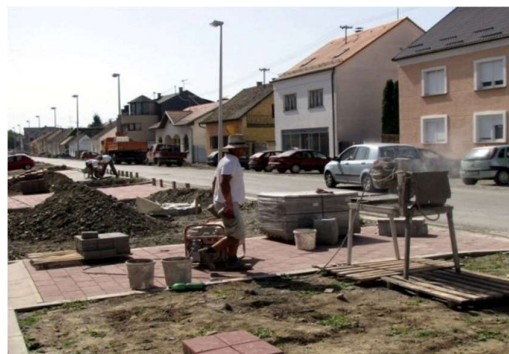
Slika 24. Rekonstrukcija Pavićeve ulice 2012. g.
