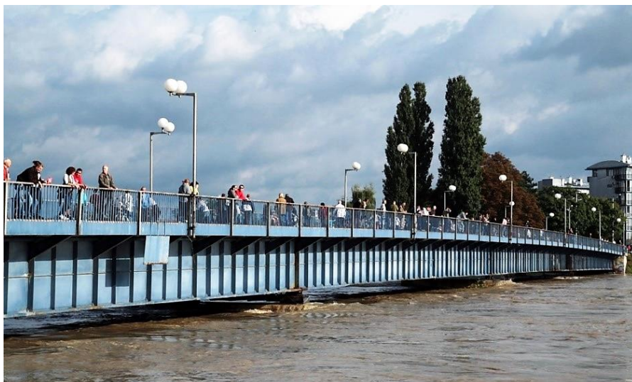
Slika 1. Savski most u Zagrebu izgrađen 1938.g. zavarivanjem
