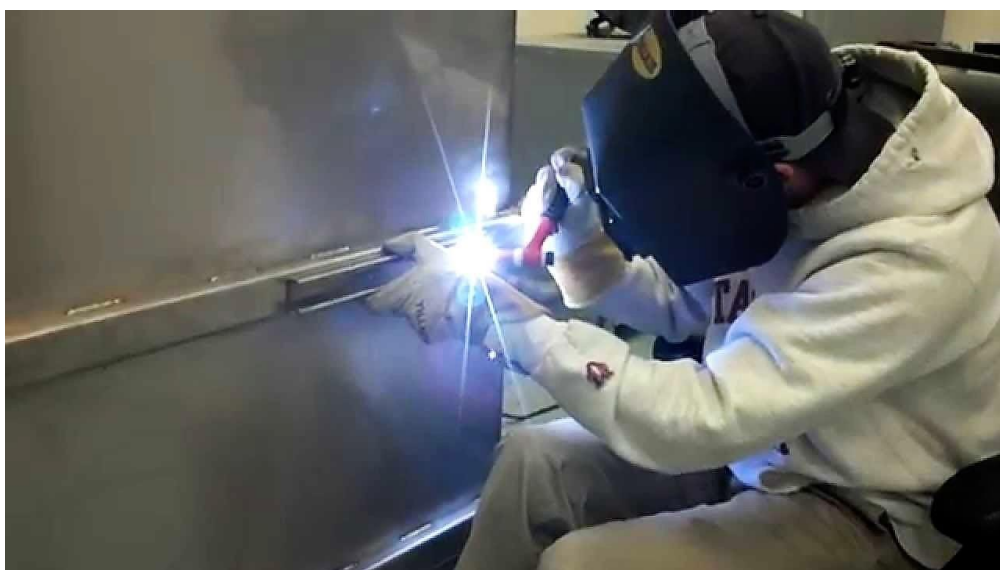
Slika 24. Popravak rashladne komore za mlijeko od nehrđajućeg čelika (Izvor: https://i.ytimg.com/vi/aNeNGchWT1Q/maxresdefault.jpg )
