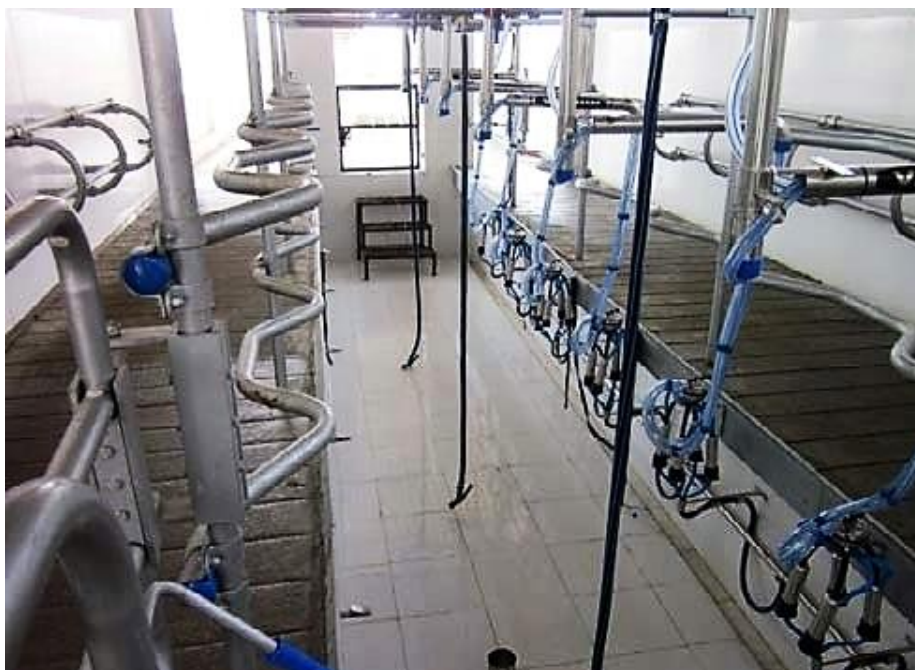
Slika 11. Sustav za mužnju krava s nehrđajućim pregradama za krave (Izvor: ISSF, 2014.)
