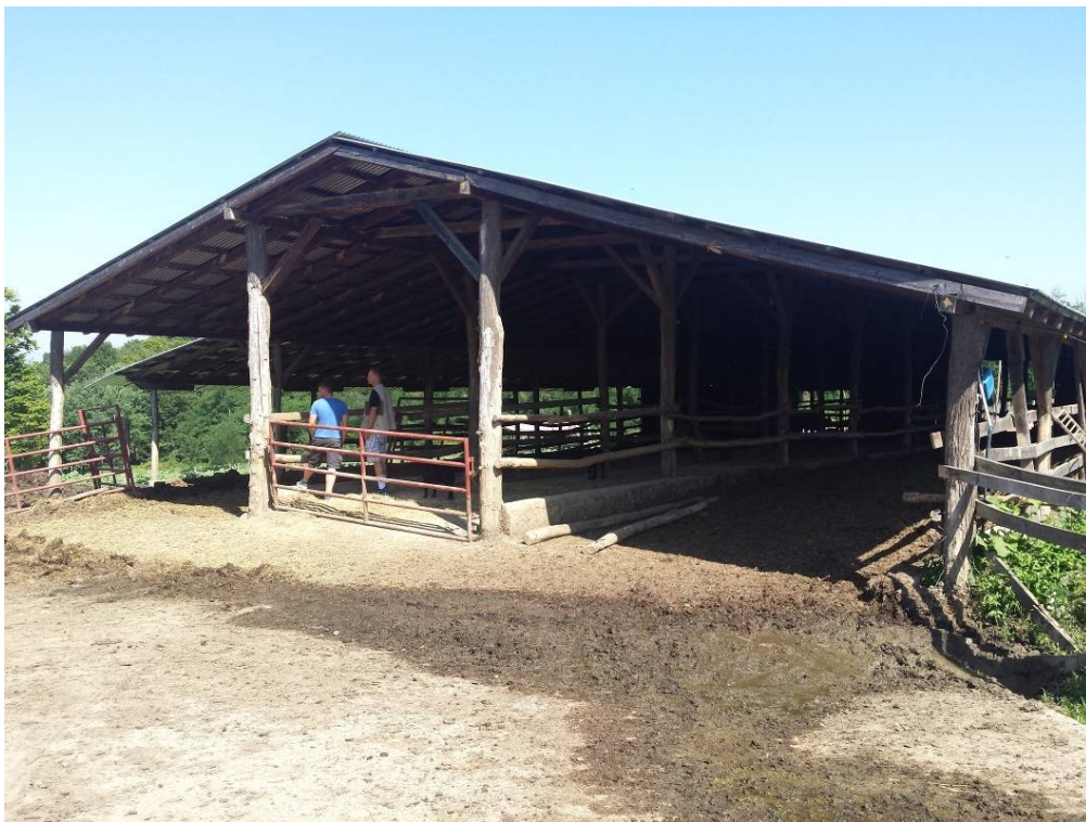
Slika 11. Zimsko sklonište stoke (pogled izvana), (Foto: Ingrid Gutttert, 2017.)
