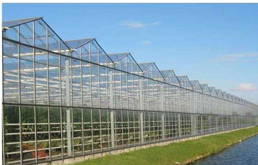
Slika 13. Konstrukcijski povezani brodovi staklenika
