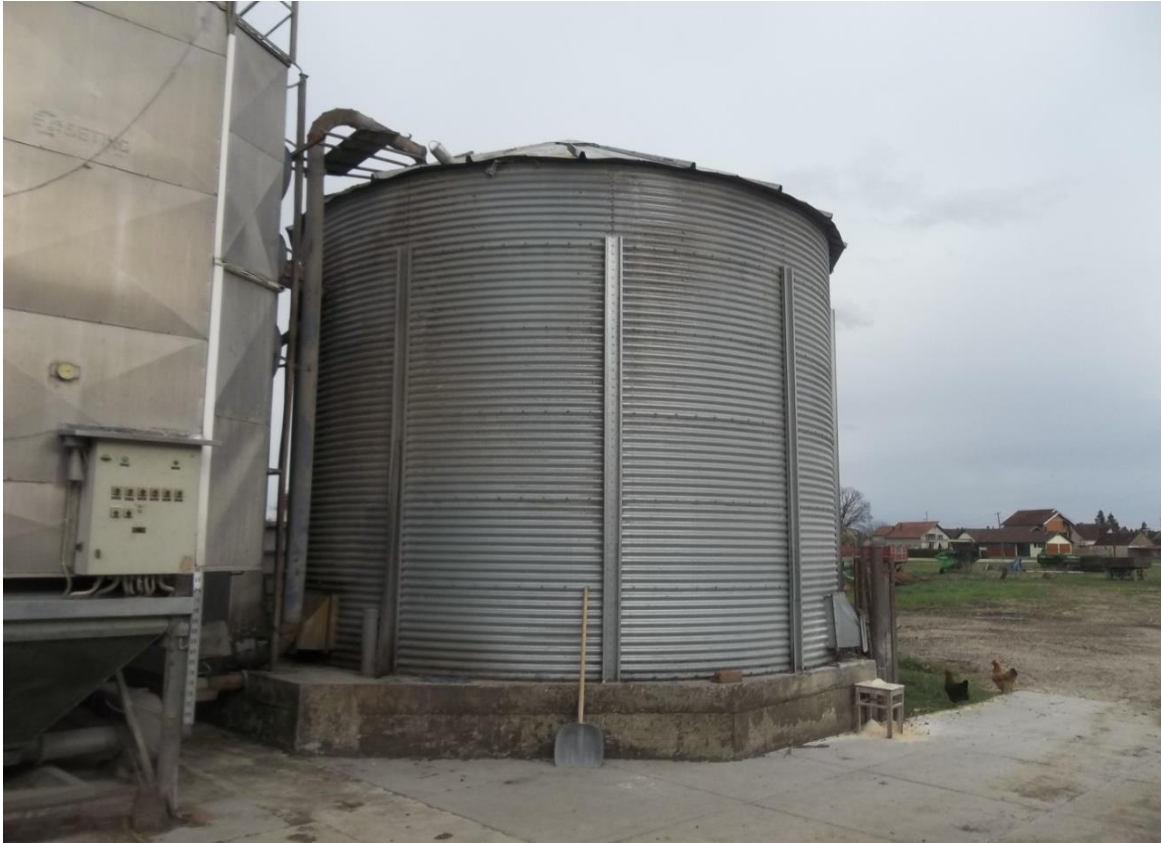
Slika 6. Silos od pocinčanog lima kapaciteta 110 tona na OPG-u Pažur Anica (izvor: Mislav Pažur)
