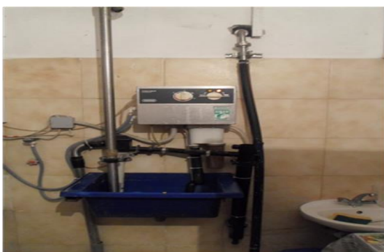
Slika 4. Postrojenje za pranje izmuzišta (Izvor: vlastita fotografija)
