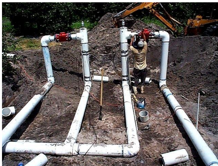
Slika 27. Ugradnja PVC cijevi za navodnjavanje plantaže agruma
