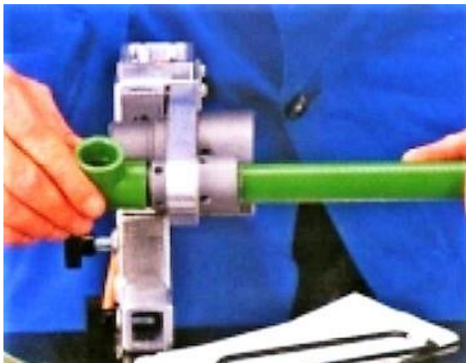
Slika 23. Zavarivanje PP-R cijevi: Zagrijavanje cijevi i koljena (Izvor: http://kalinic.info/strucni/cijevi.pdf )
