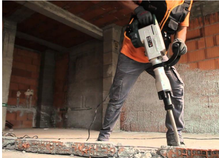
Slika 2. Izvođenje građevinskih radova korištenjem vibrirajućeg alata (URL3)
