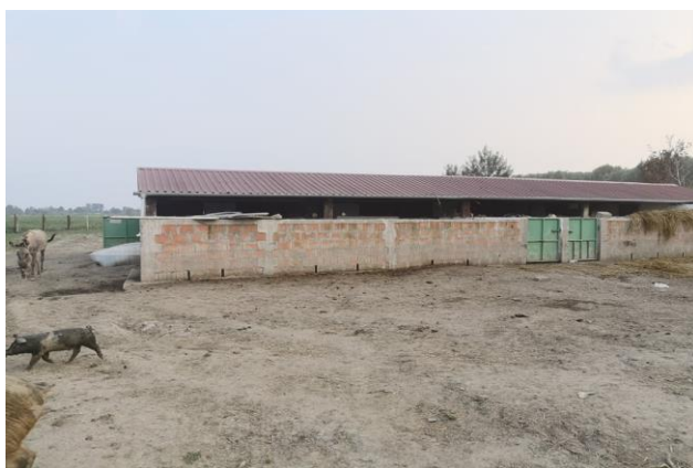
Slika 10. Zidani objekt za crne slavonske svinje na OPG-u „Marić“
