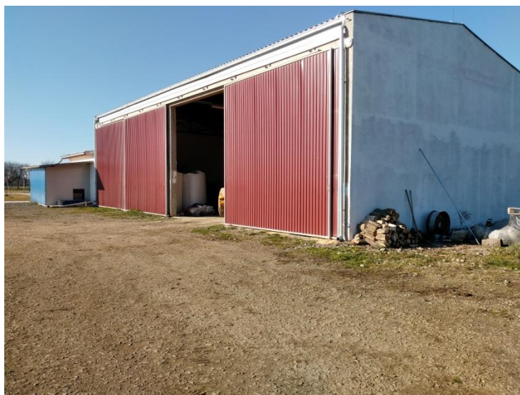
Slika 6. Nadstrešnica za skladištenje hrane
