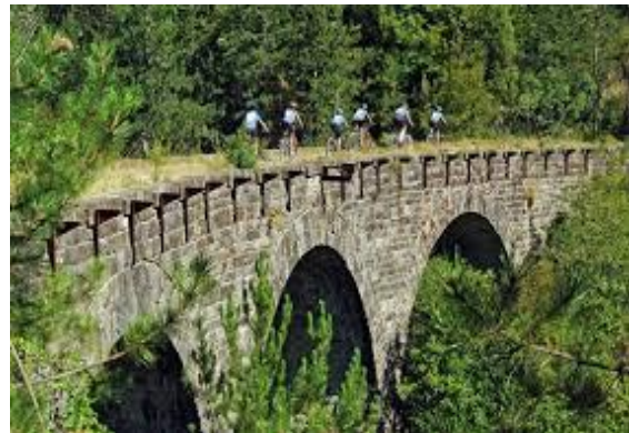
Sl. 25) Obnovljena trasa povijesne uskotračne pruge Parenzane, danas jedan od glavnih akcenata turističke ponude
