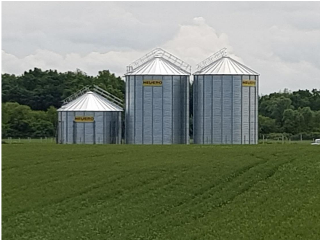
Slika 16. Izgradnja „Neuero“ silosa firme „Kolić d.o.o.“ (Izvor: Marin Kolić)
