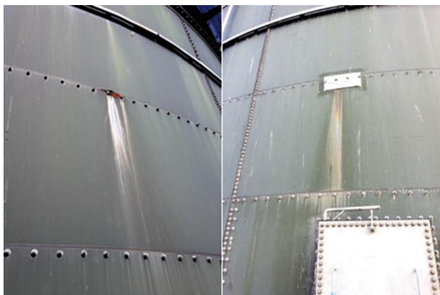
Slika 30. Oštećenje i zakrpa na čeličnom digestoru
