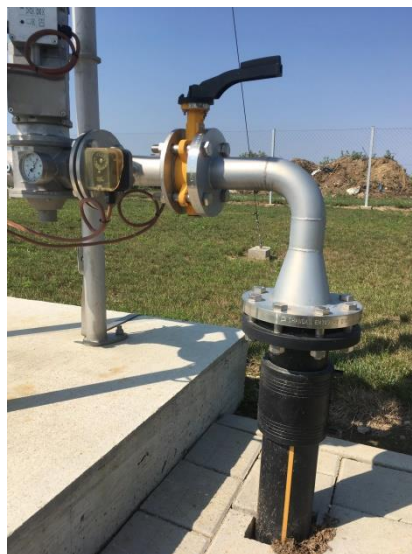
Slika 27. Izolirani cjevovod bioplina do baklje za spaljivanje
