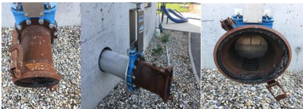
Slika 13. Ravnomjerna korozija na izlaznoj cijevi za odvoz digestata
