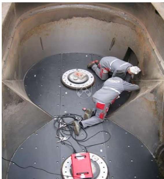
Slika 29. Postavljanje posebnih plastičnih obloga
