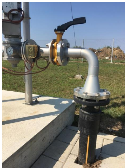
Slika 27. Izolirani cjevovod bioplina do baklje za spaljivanje
