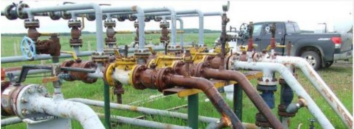
Slika 26. Korozija cjevovoda
