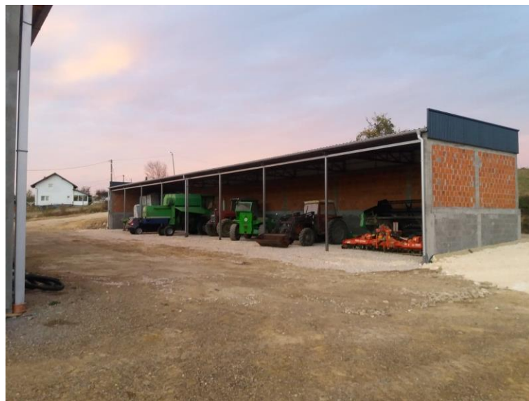
Slika 4. Garažiranje strojeva pod nadstrešnicom
