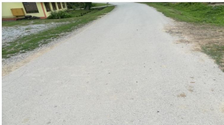
Slika 7: Asfalt (izvor: Ivan Kamenčak, 2019.)
