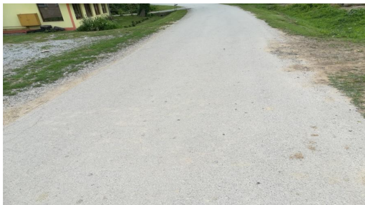
Slika 7: Asfalt (izvor: Ivan Kamenčak, 2019.)
