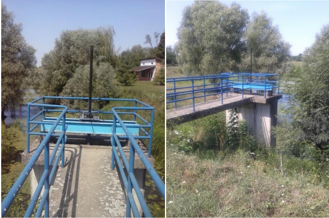
Slika 29. Ustava na Gatskom kanalu (foto F.Vrbanić)
