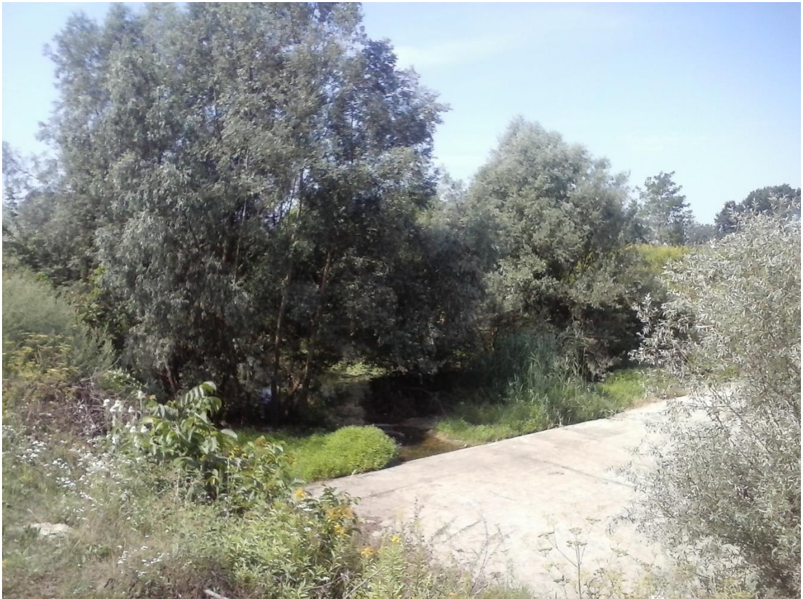
Slika 18. Prag u Gatskom kanalu(foto F.Vrbanić)
