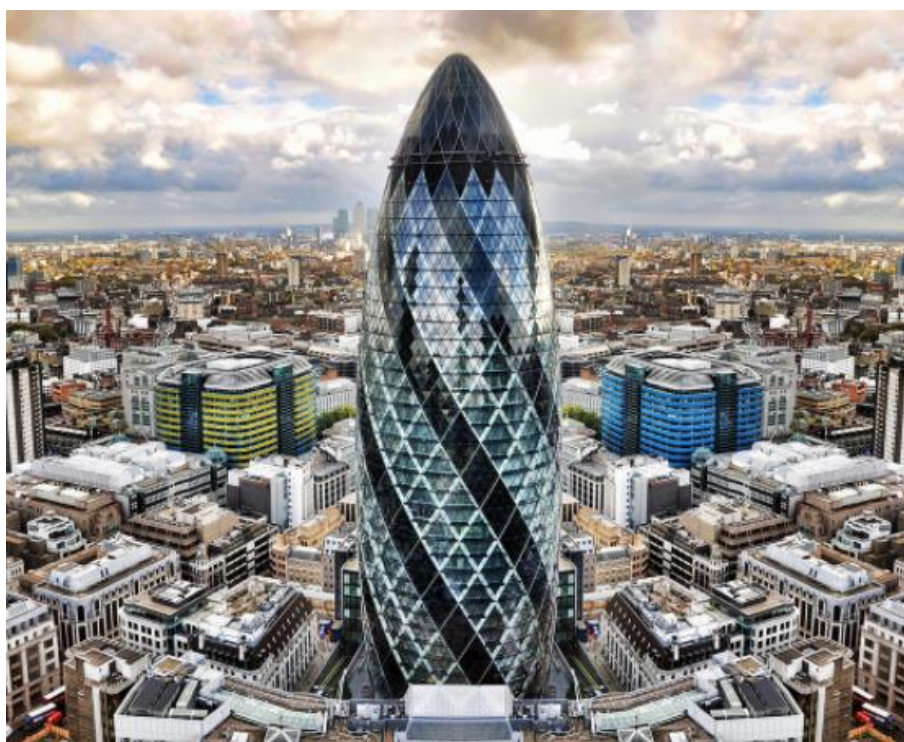
Slika 1. Poslovni neboder u Londonu izrađen od aluminijske konstrukcije ( https://www.aluminiumleader.com/application/construction/ )
