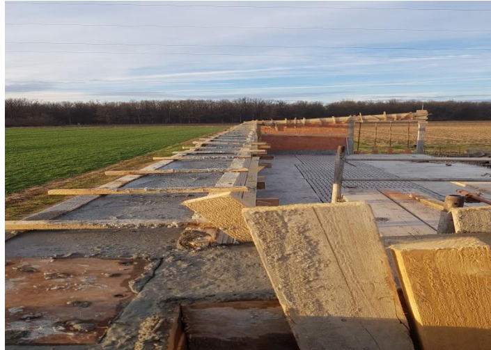
Slika 14. Gradnja objekta za tov junadi
