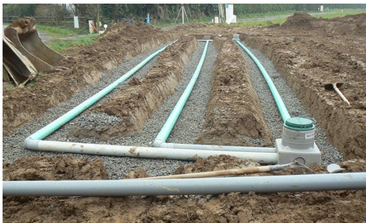
Slika 9. Prikaz sustava za drenažu
