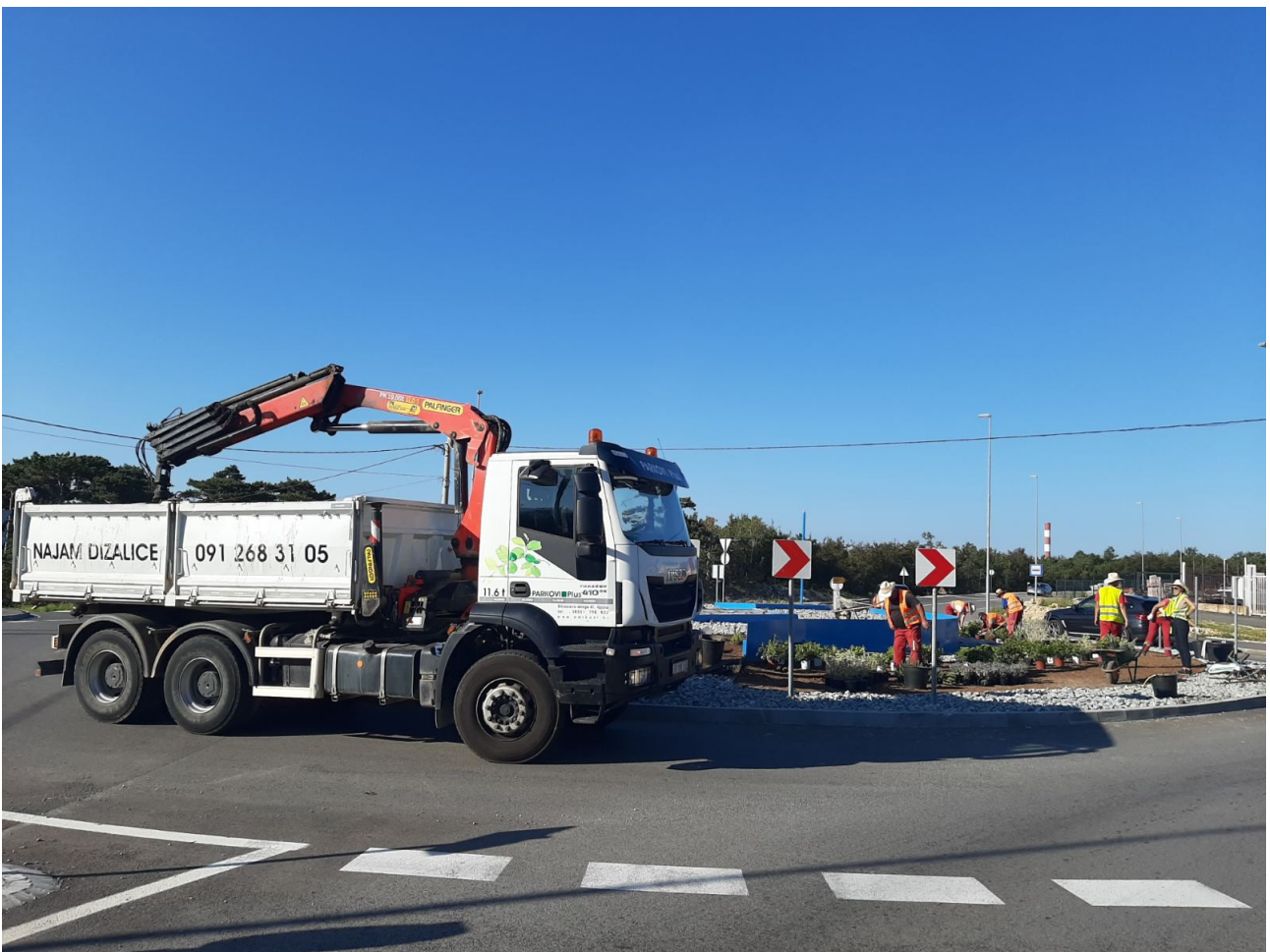
Slika 5: Izvođenje radova na rotoru Šoići, Kostrena, 2020.
