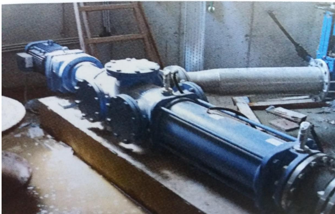
Slika 9. Wangen procesna crpka
