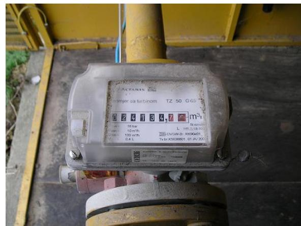
Slika 19. Mjerenje potrošnje plina plinskom turbinom (vlastita fotografija)
