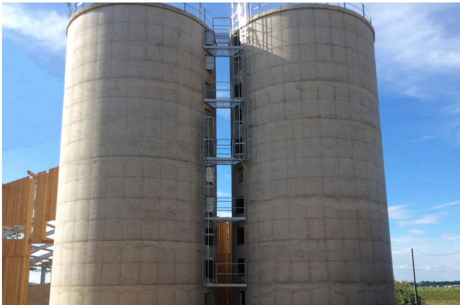
Slika 7. Vertikalni silosi (silo tornjevi)
