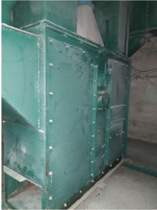
Slika 9. Podnožje elevatora Kovinar
