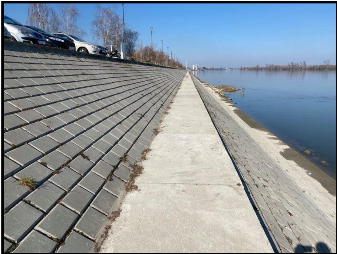
Slika 3. Obaloutvrda uz šetnicu u Vukovaru – novija gradnja
