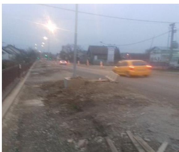
Slika 4) Postavljena rasvjetna tijela (Izvor: Autor, 2020.)
