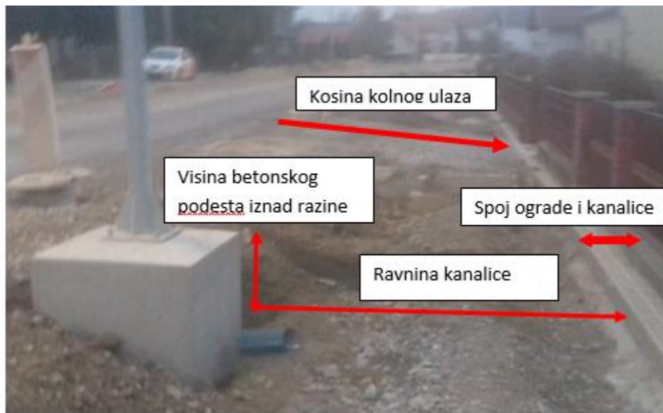
Slika 8) Betonski stupovi za rasvjetna tijela koji nisu postavljeni na način da ih zelena površina skriva, tj. da su postavljeni u razini košnje travnjaka, već strše (Izvor: Autor, 2020.)
