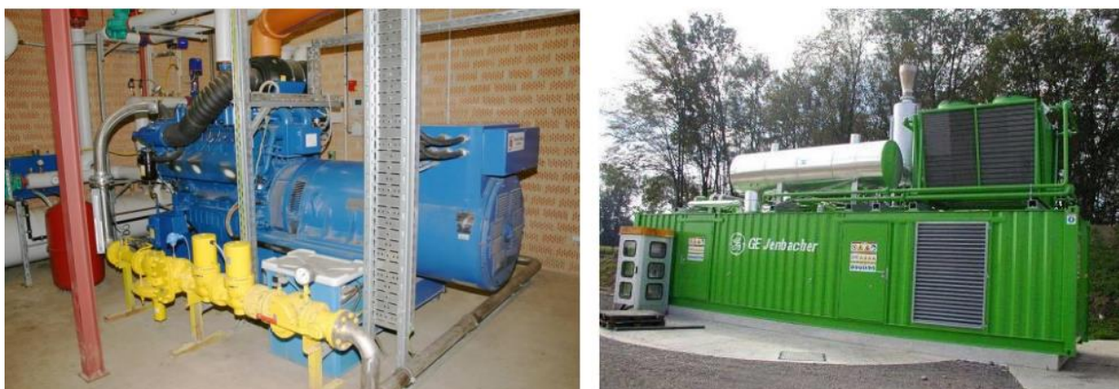
Slika 20. Plinski motor
