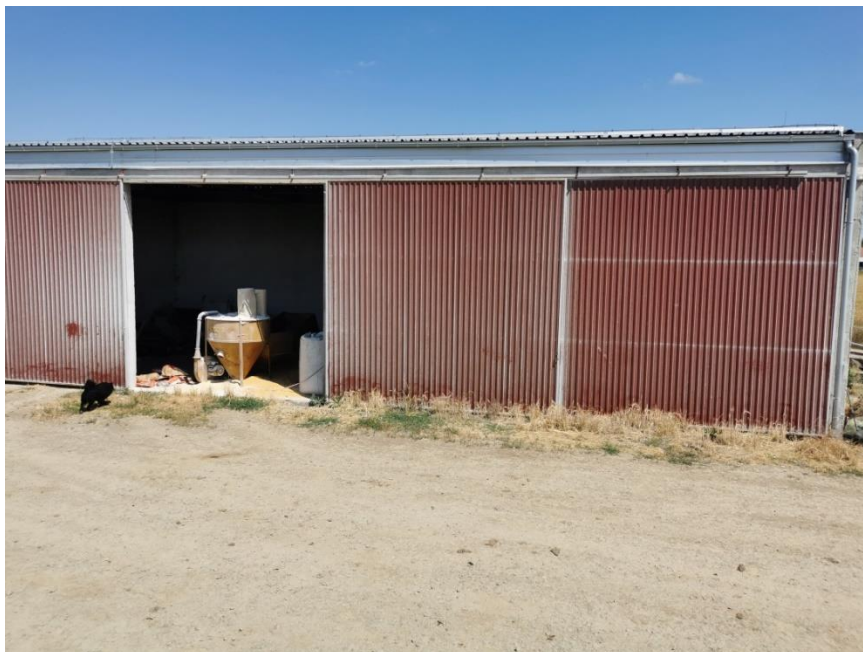
Slika 4. Podno skladište za hranu
