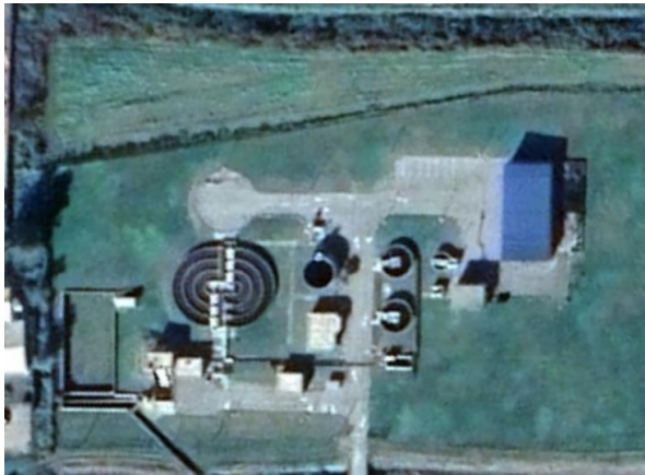
Sl. 26. Uređaj za pročišćavanje otpadnih voda grada Donjeg Miholjca
