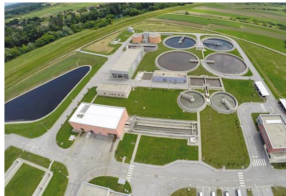
Sl. 29. Objekti za pročišćavanje otpadnih voda grada Karlovca i Duge rese
