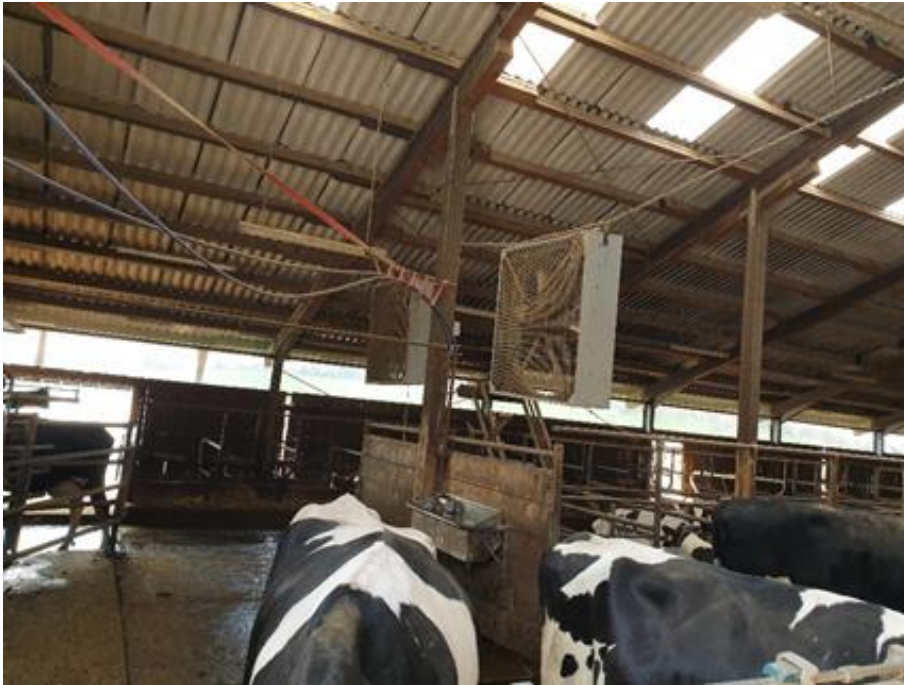
Slika 7. Ventilatori u staji za odvođenje topline putem strujanja zraka (foto: Vučković, G.)
