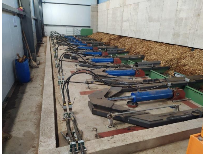
Slika 28. Upotreba hidrauličkih cilindara u procesu kogeneracije
