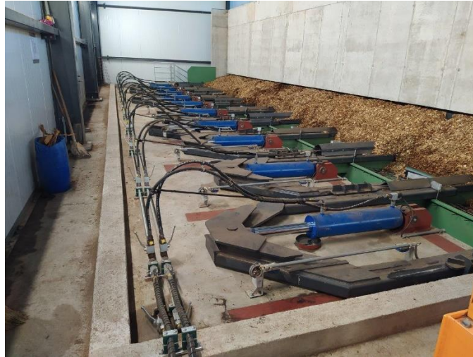
Slika 28. Upotreba hidrauličkih cilindara u procesu kogeneracije
