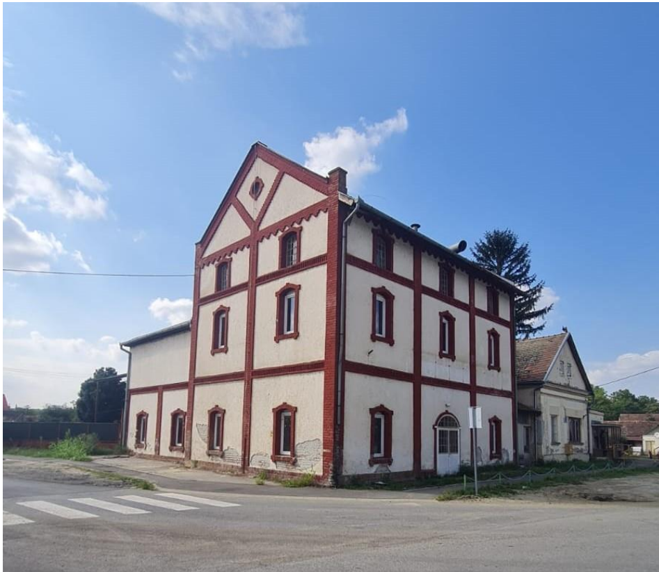
Slika 1. Zgrada nekadašnje kudjeljare u Črnkocima (Jonjić, A., 2022.)
