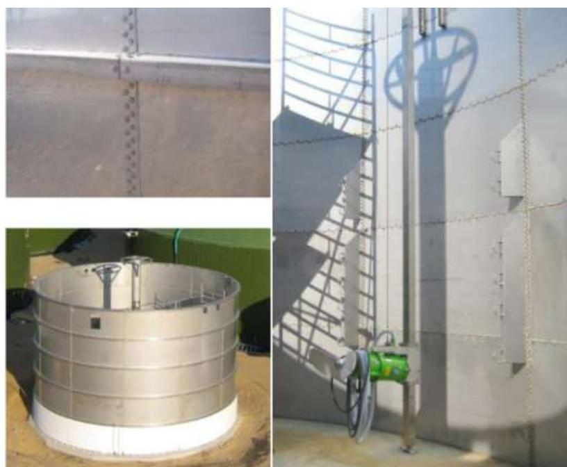
Slika 28. Spremnići od nehrđajućeg čelika za skladištenje gnojnica i fermentaciju bioplina
