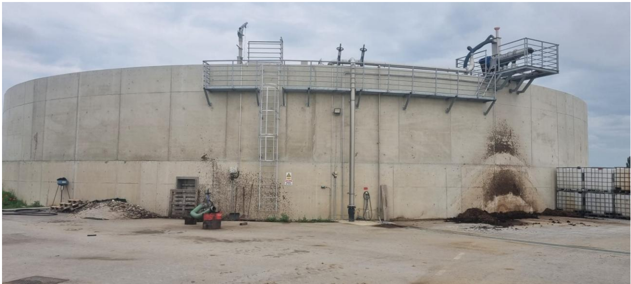
Slika 11. Skladište digestata, “laguna”
