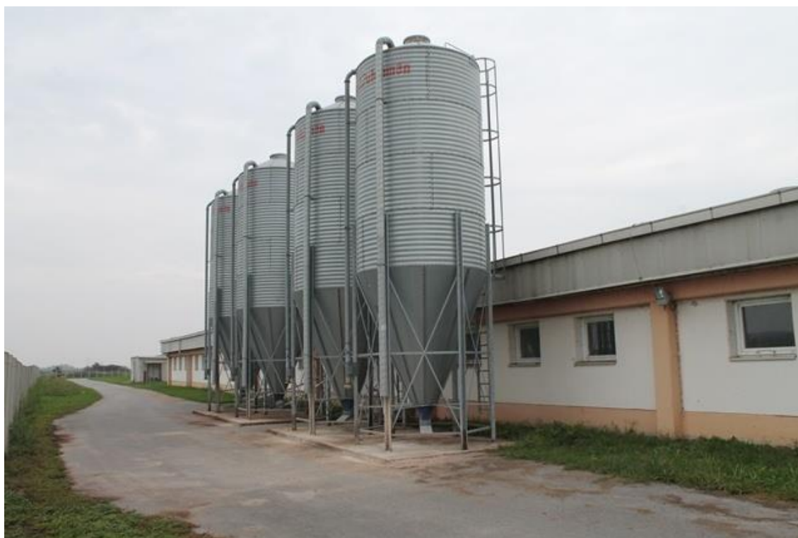
Slika 1. Silosi za hranu ( T.Svrtan )
