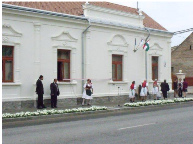
Slika 6.: Renovirana zgrada općine
