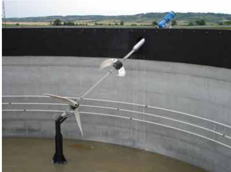
Slika 22. Miješalica s lopaticama smješšana unutar fermentatora. Izvor: http://www.eihp.hr/hrvatski/pdf/Prirucnik_za_bioplin_w.pdf
