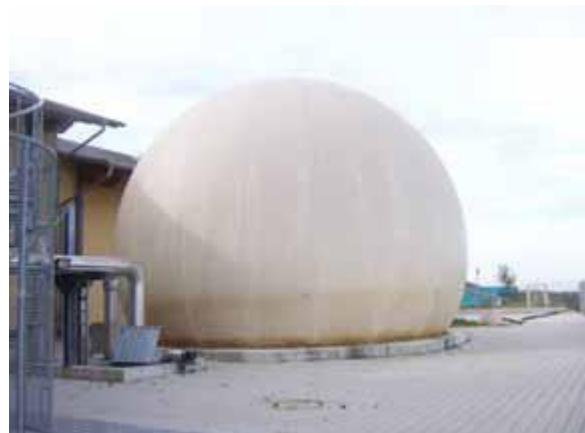
Slika 23. Vanjsko niskotlačno spremište za skladištenje plina.
