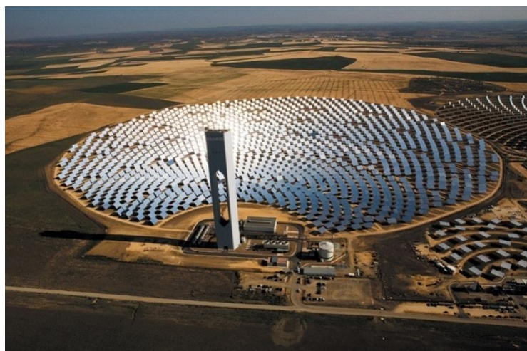
Slika 7. : STE sa tornjem u Španjolskoj snage 11 MW
