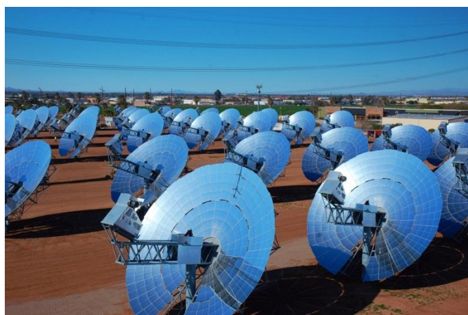
Slika 8. : STE sa paraboličnim tanjurem
