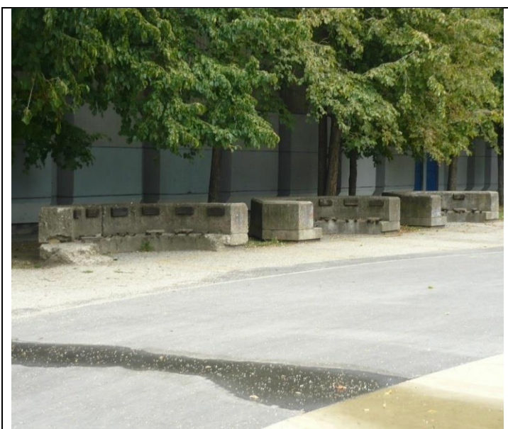
Sl.11) Kamene klupe na obnovljenoj strani parka Zrinjevac
