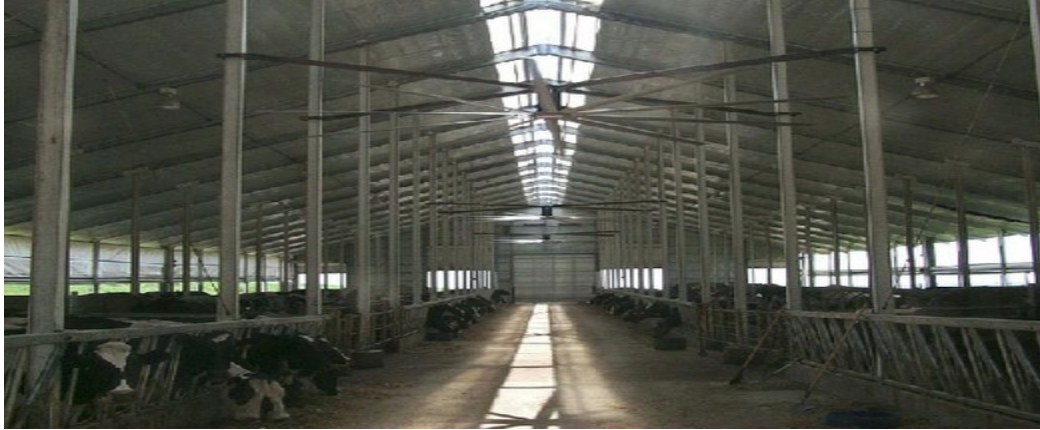
Slika 4. Ventilatori malih brzina i velikih protoka
