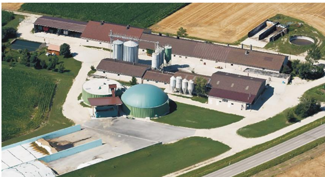
Slika 6. Bioplinsko postrojenje u Dvoru iz zraka
