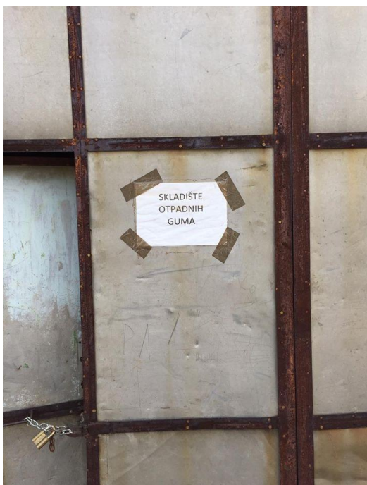
Slika 19. Skladište za zbrinjavanje otpadnih guma
