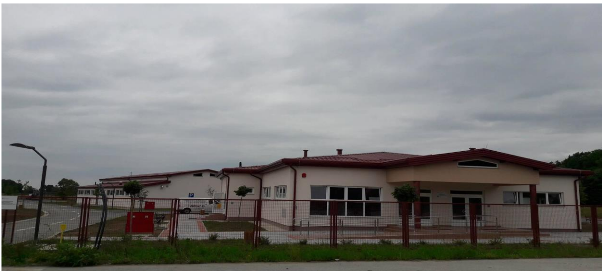
Slika 6. Upravna zgrada PPID
